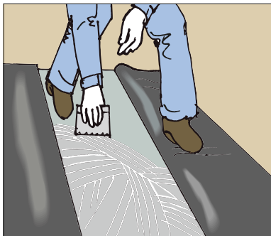
●塩ビ床シートの施工に
