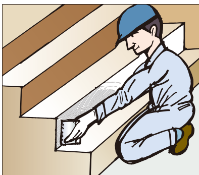
●階段の立ち上げ、ササラ巾木の施工
