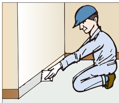
●ソフト巾木・ワイド巾木の施工
