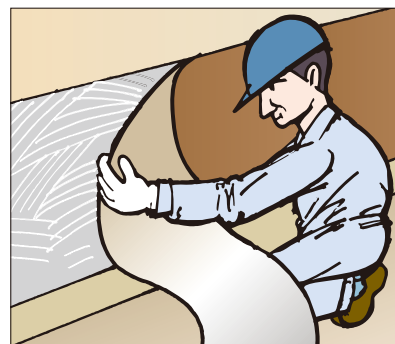
●塩ビタイル・シートの腰壁への施工
