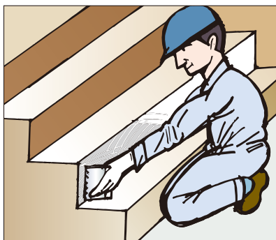
●階段の立ち上げ、ササラ巾木の施工
