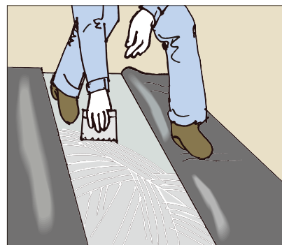
●ビニル床シートの施工に
